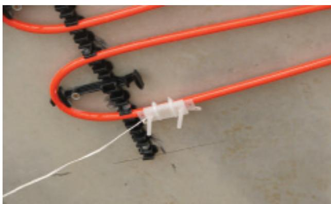
Primjer montaže potpornog distancera kod izrade luka cijevi (crni element okomit na vodilicu) Bijeli element je osjetnik vlage priključen na modul i povezan sa automatskom.
