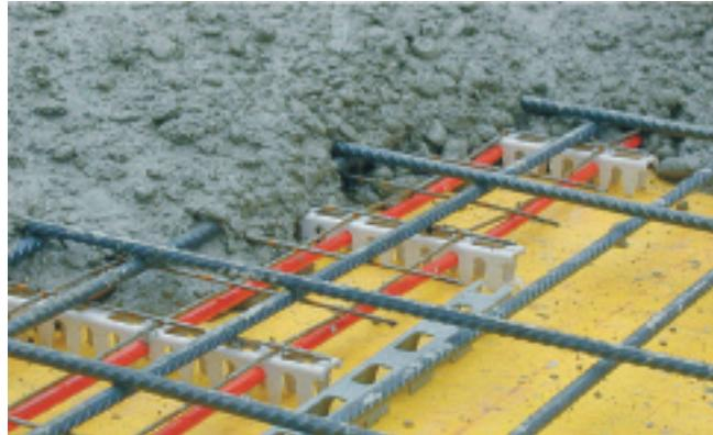
Izljevanje betona preko modula na oplati (betoniranje stropne ploče)
