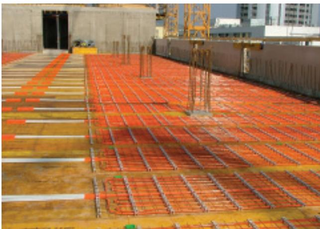
Povezivanje modula na oplati po shemama s nacrtu
