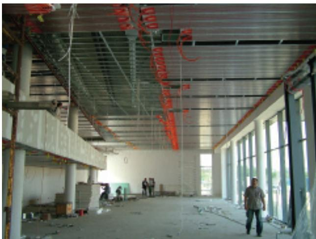
6. Moduli se montiraju i povezuju na različitim nivoima stropa bez značajnih gubitaka isijavajuće snage na istu površinu
