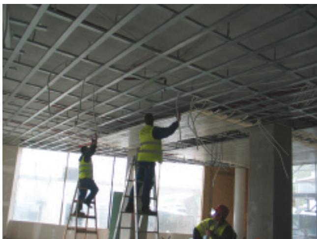
3. Montaza modula prema nacrtima na spušteni strop
